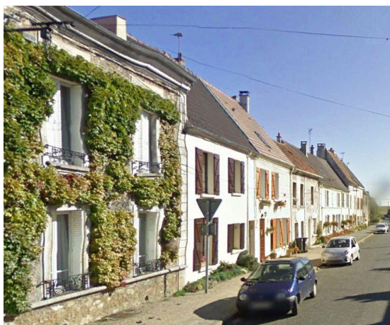
Font bâti rue Saint-Jean
